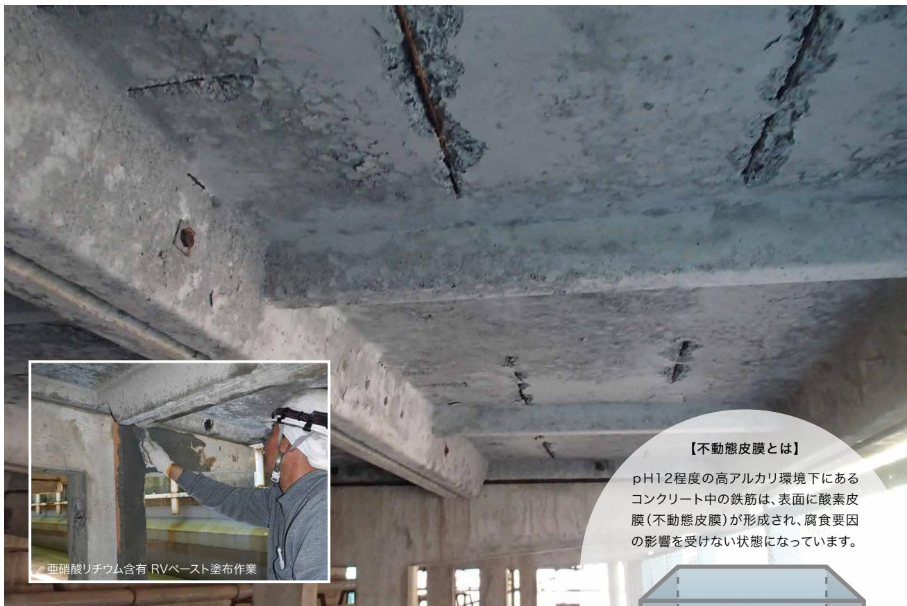
プール槽やプールサイド躯体の裏面は、鉄筋コンクリートが苦手とする湿度や塩素水分などの温床となりがちです。そしてこれらの水分や塩素・酸素が不動態皮膜を破壊し、鉄筋の発錆が始まります。「亜硝酸リチウム」を含有したセメントベーストを塗り込むリバンプ工法は、破壊された鉄筋の不動態皮膜を再生し、錆の進行を抑制することで、コンクリート躯体の耐久性を高める効果を発揮します。
