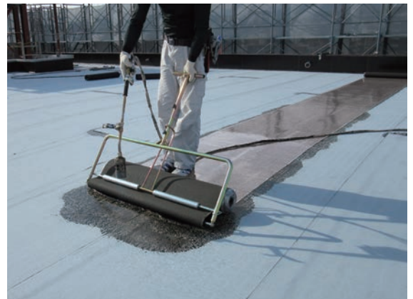
溶融釜を使用することなく、たっぷりの溶融アスファルトを使って、水密性を確保します。
