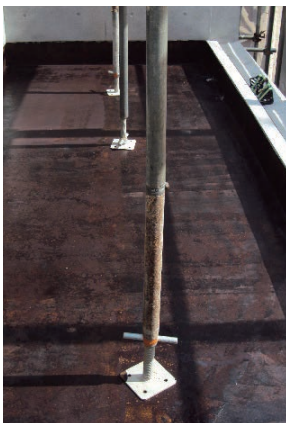
プライマー塗布
