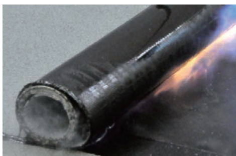
改質アスファルトシート防水・トーチ工法
