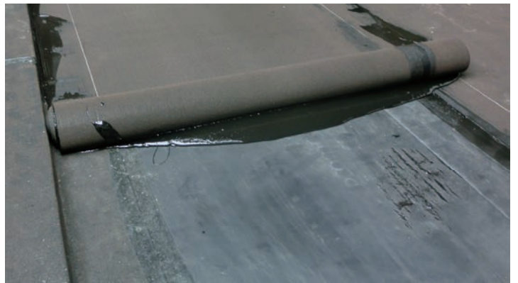
攪拌したレイヤコートをを用いてレイヤルーフを流し貼り
