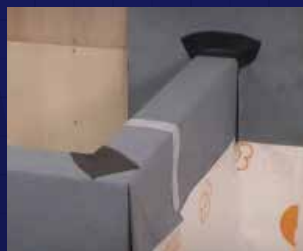
バルコニー手すり壁のコーナー
