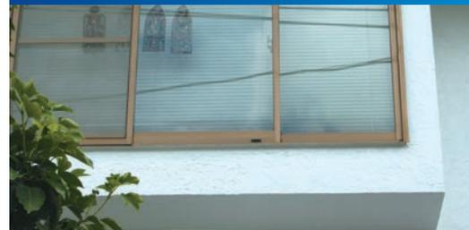
窓などの開口部では、壁との取合い部分からの雨水が枠を伝わって上から下に流れ、開口部枠の下側から下張材の内側に浸入しやすくなります。そのため、雨水を切れる納まりにする必要があります。また、下張材のように面に覆うタイプの材料ですと、どうしても隅角部に覆いきれない部分(ピンホール)が生じてしまいます。そこで、伸張性のある材料で、ピンホールを塞ぐことが必要になります。
